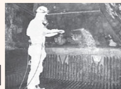
除去作業の様子
