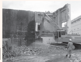
解体作業の様子
