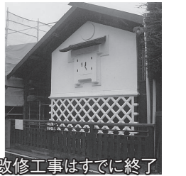
邸の改修工事はすでに終了
