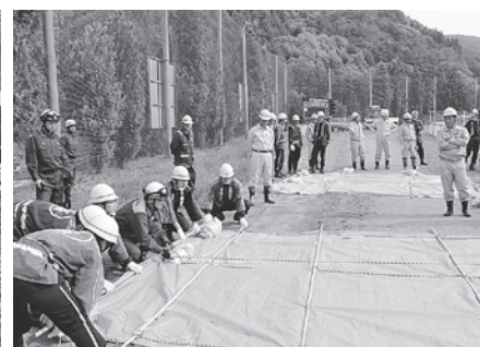
シート張り工法
