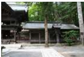
春宮幣拝殿及び片拝殿
