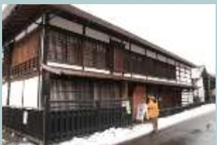
登録有形文化財 旧伏見屋店舗兼主屋
