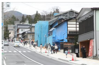
復元工事中の町屋建築様式の建物
