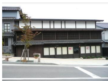
復元された建築物
