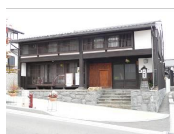
復元された建築物
