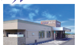
えころホールみずべ 下諏訪町東赤砂4694-4
