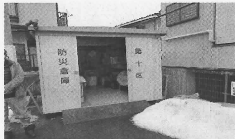
第10区防災倉庫
