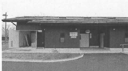
赤砂崎公園管理棟横倉庫
