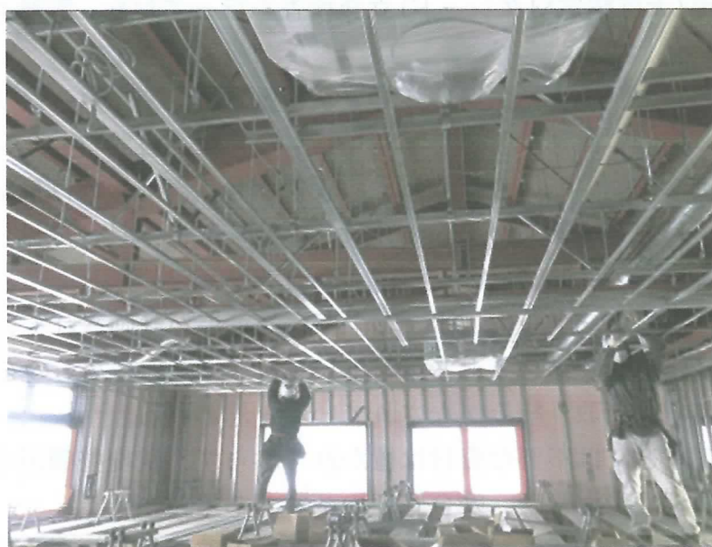
管理棟2階 天井LGS・耐震仕様
