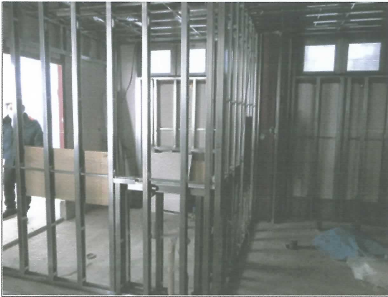
管理棟1階 LGS施工
