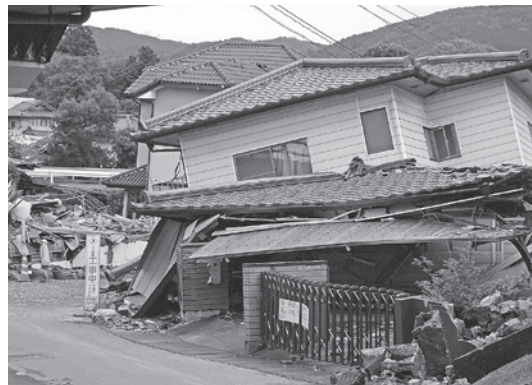
熊本地震被害状況
