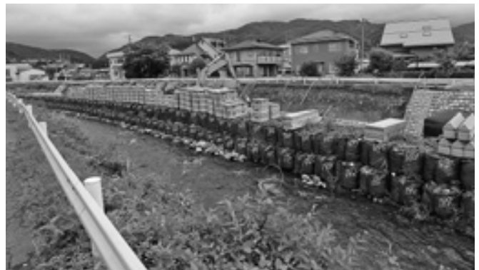
【1】 砥川河川改修工事 工事現場(富士見橋上流左岸)
