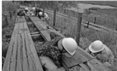
クラウドファンディングによる八島湿原木道補修
