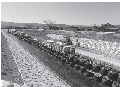
工事現場（JR橋上流/右岸）
