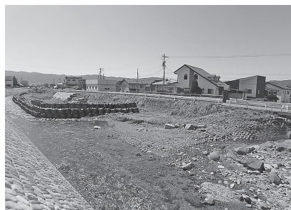
工事現場（福沢川との合流部/右岸）
