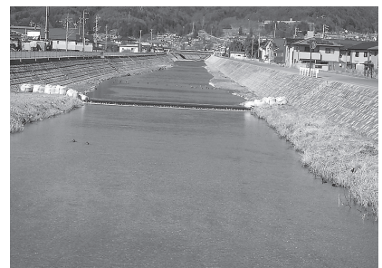
改修後の様子（砥川橋上流）
