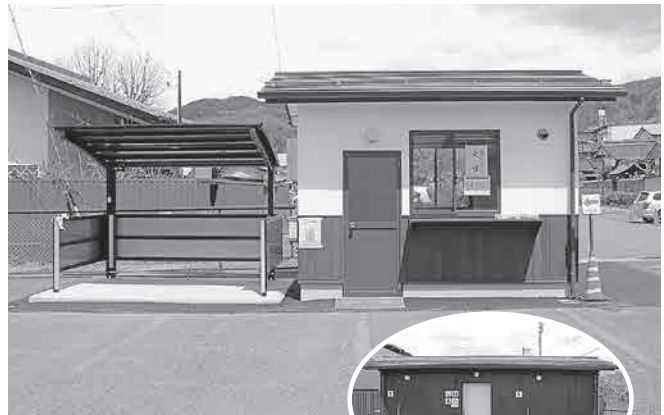
平成30年度 に整備のトイレ
