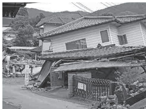
熊本地震被害状況
