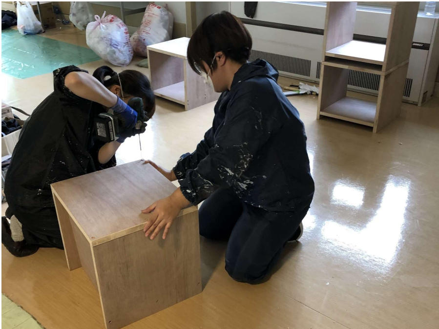
(リノベーション作業の様子)
