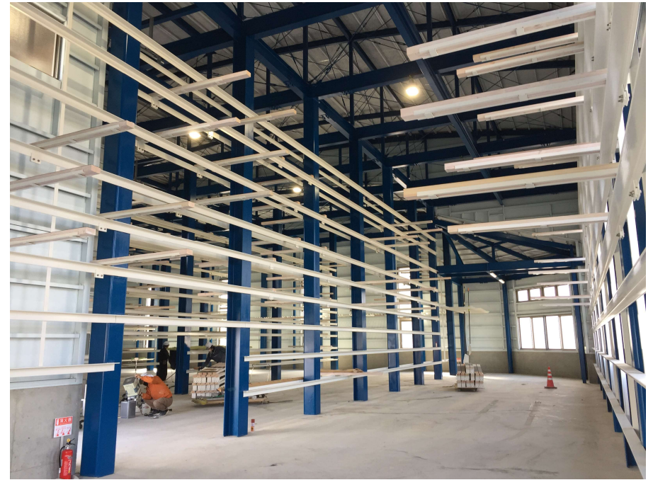
(完成の様子(内観))
