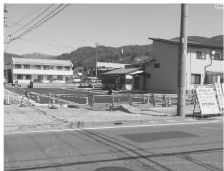
工事が進む西大路交差点
