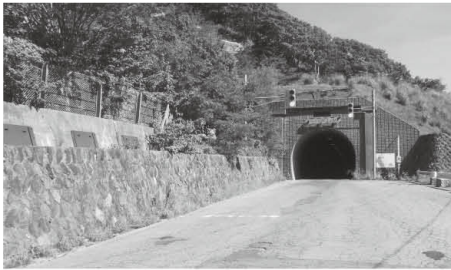
旧和田トンネル（下諏訪側）
