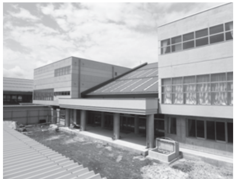
改修工事が進む南小学校
