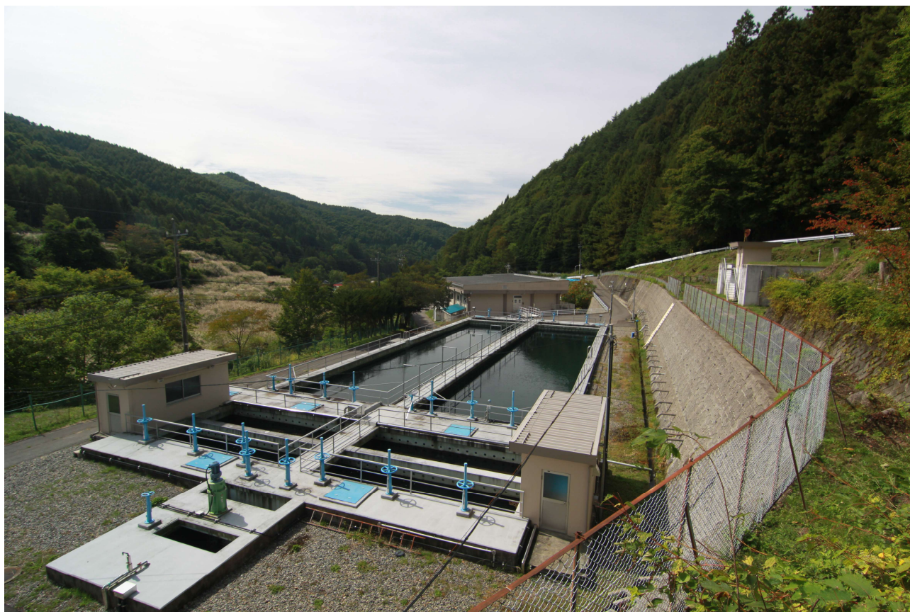
下諏訪町東俣浄水場
