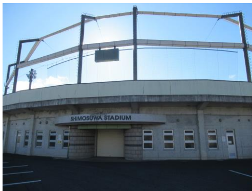
下諏訪スタジアム 外観
