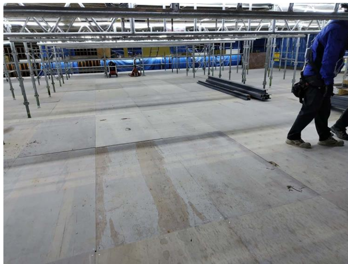
【全面荷受構台の状況写真】
