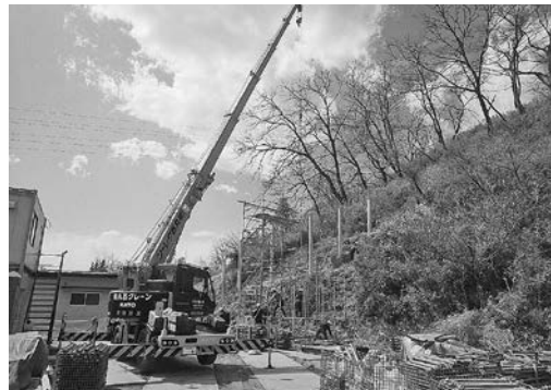
【3】 武居地区急傾斜地崩壊対策工事
