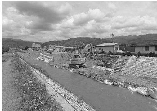
【1】 砥川河川改修工事 (赤砂橋上流左岸)
