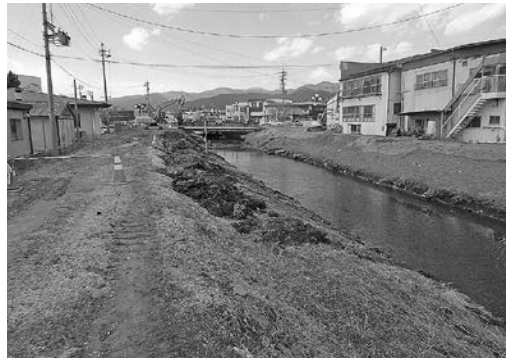
【2】 承知川河川改修工事 (承知川橋下流)
