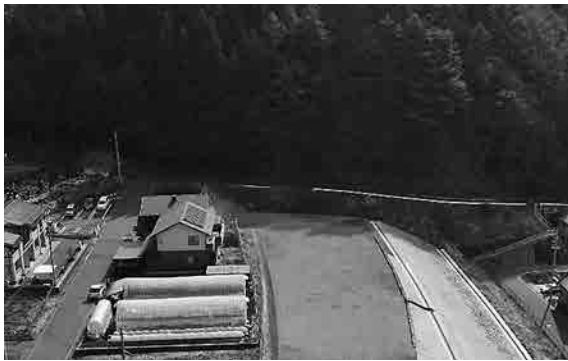
長地工区 施工前【平成31年3月末】
