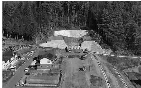
長地工区 施工中【令和2年2月末】
