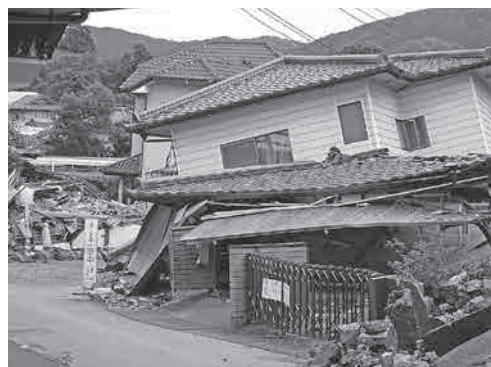
熊本地震被害状況
