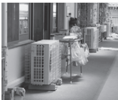
エアコン設置が進む さくら保育園
