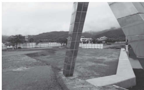
整備された新艇庫建設予定地
