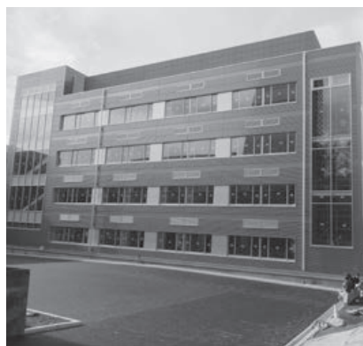
完成が近い9号館
