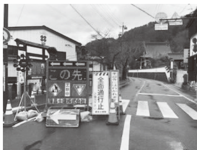
国道142号線の道路規制
