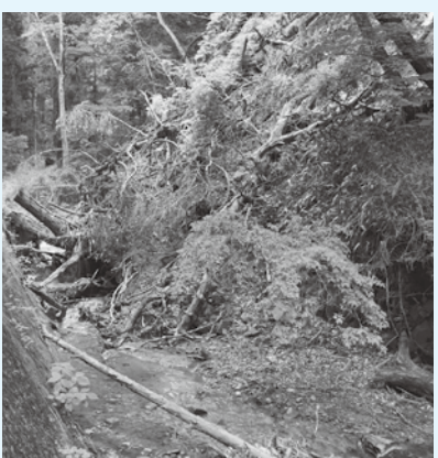
斜面崩落による福沢川の惨状
