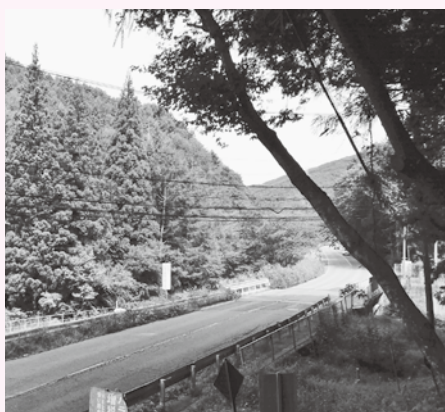
142号線沿いの危険な木
