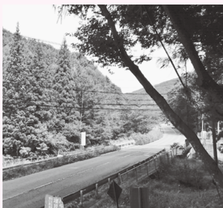
142号線沿いの危険な木
