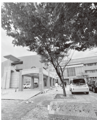
2年前の能登半島地震の傷跡が残る庁舎
