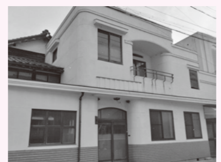
改修予定の旧矢崎商店
