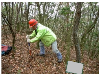
③人力で50cm程度掘削し、振動源の穴を作ります
