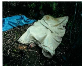
⑤飛石防止用のシートを設置します
