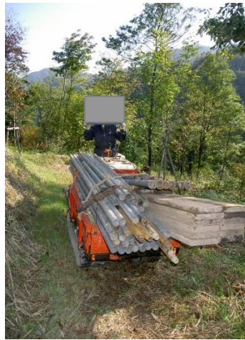
運搬車による機材搬入の例
