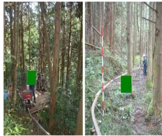
モノレールによる機材搬入の例
