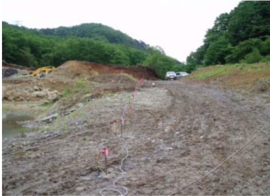
観測測線の設置状況
