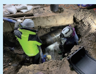
▲送水管の漏水修繕工事
