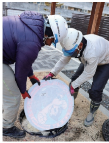
▲マンホール設置風景
