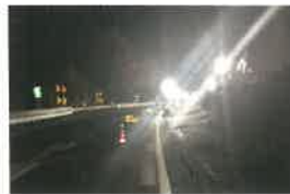
テーパ部照明の設置例
