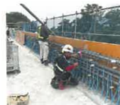
現場打ち壁高欄の施工
