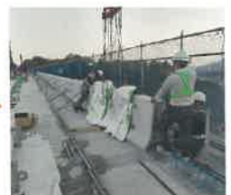
プレキャスト壁高欄の施工
