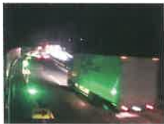
視線誘導の設置例
