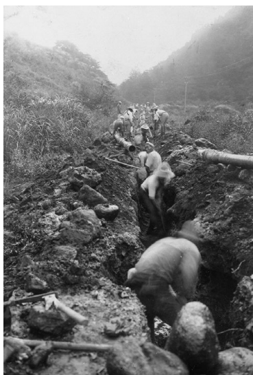
送水管埋設工事 (蝶ヶ沢付近)
