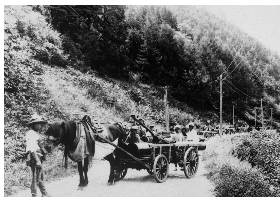
荷馬車による 送水管運搬
