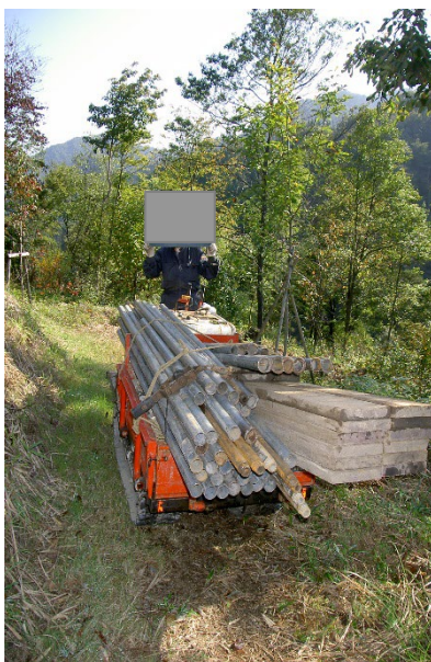
運搬車による機材搬入の例
