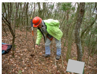
掘削した深さ 50cm 程度の発破孔に火薬を充填し防爆シートを被せた上で発破します
