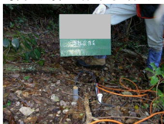
バイパスルート上にケーブルと振動を感知する受振器を設置します
