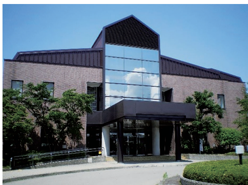
総合文化センター改修事業は、令和6年度の大ホール改修に続き、小ホール及びもみの木モール等の改修を行います。
