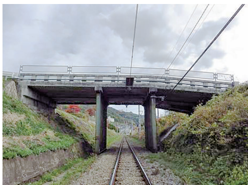
高木橋架け替え工事は令和8年度までを予定しています。
