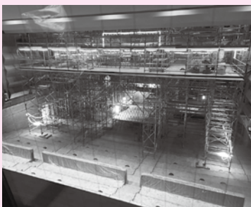
改修工事中の 下諏訪総合文化センター
