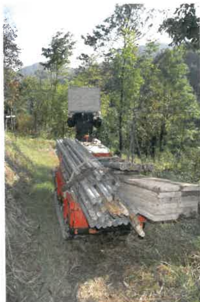
運搬車による機材搬入の例
