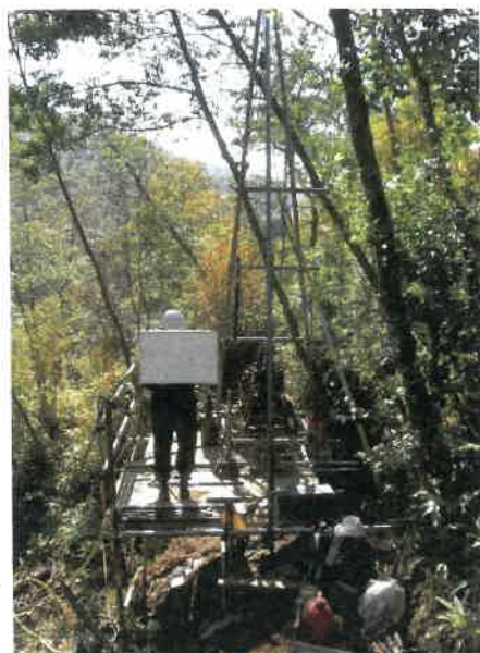
ボーリング作業の例
