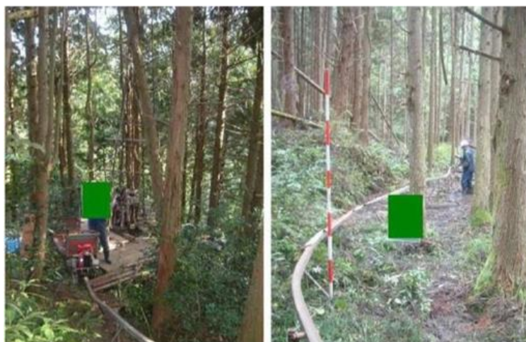
モノレールによる機材搬入の例
