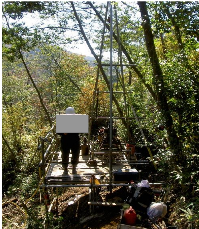
ボーリング作業の例
