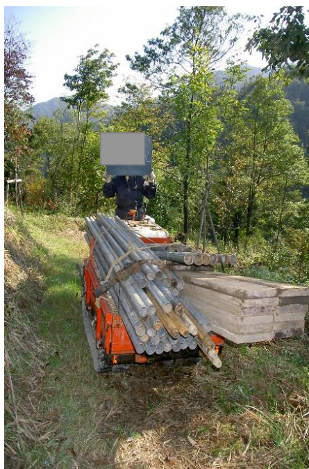
運搬車による機材搬入の例
