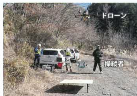
ドローン操作による測量作業状況
