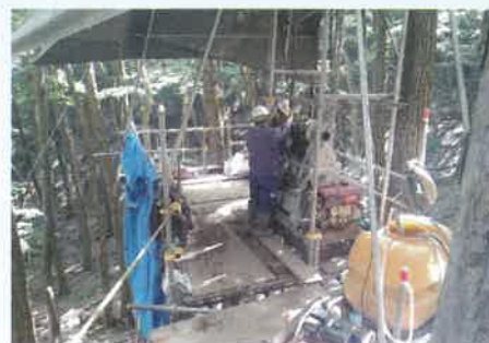
地質調査作業状況
