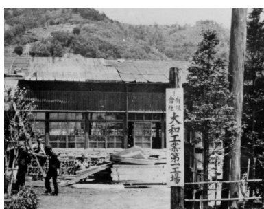
味噌蔵を改修した工場
