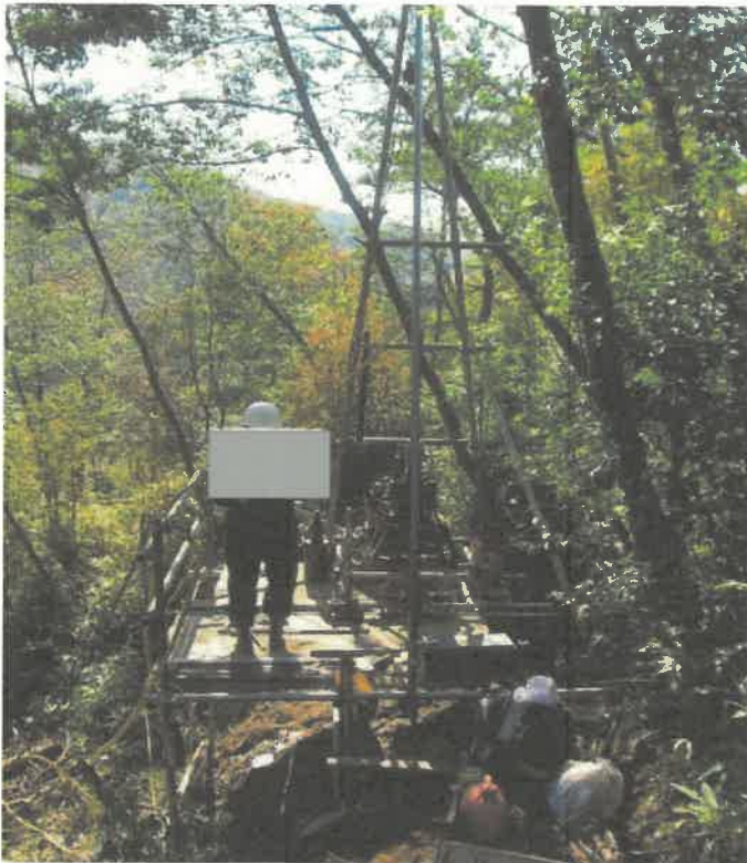
ボーリング調査、足場仮設状況の例
