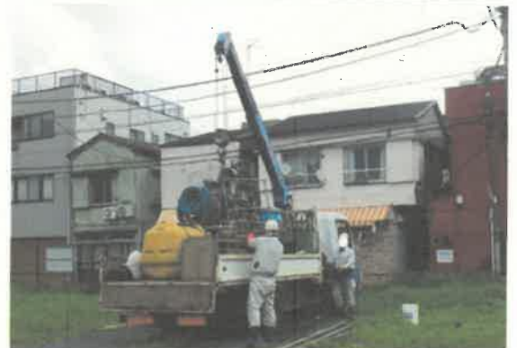
クレーン付きトラックによる機材搬入の例
