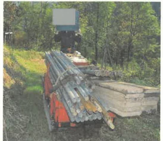
運搬車による機材搬入の例
