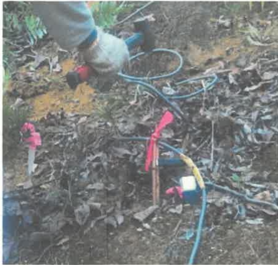
電極・観測線の設置状況
