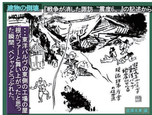
⑦図 昭和19年の昭和東南海地震の際の被害の様子（現諏訪市庁舎の場所）。工場が全壊し、地割れができ、噴砂現象が発生したことがわかる。
