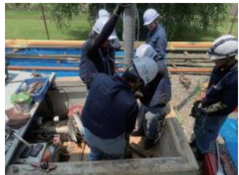
温泉揚湯ポンプ入替工事
