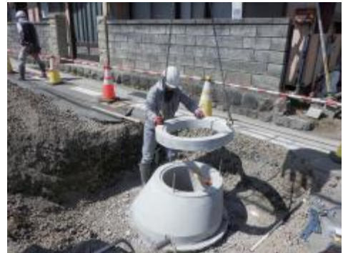
マンホール設置工事
