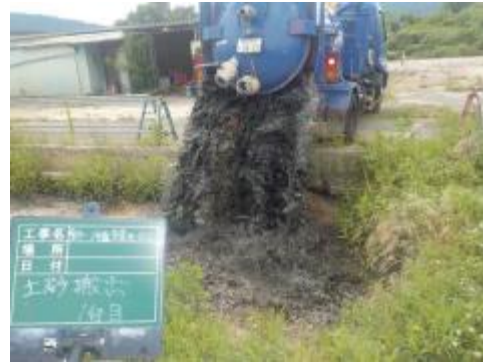
鰻沢浚渫工事
