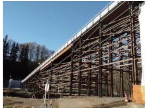
国道20号下諏訪岡谷バイパス 砥川1号橋仮橋
