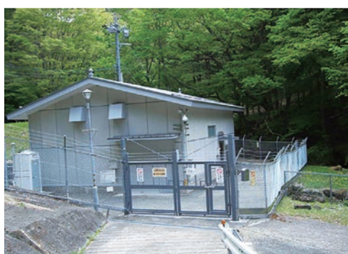
蝶ヶ沢発電所（現在）
