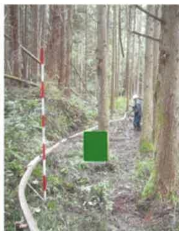
モノレールによる機材搬入の例
