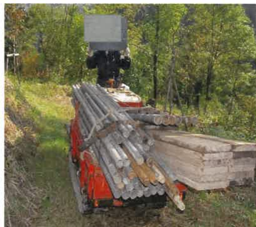
運搬車による機材搬入の例
