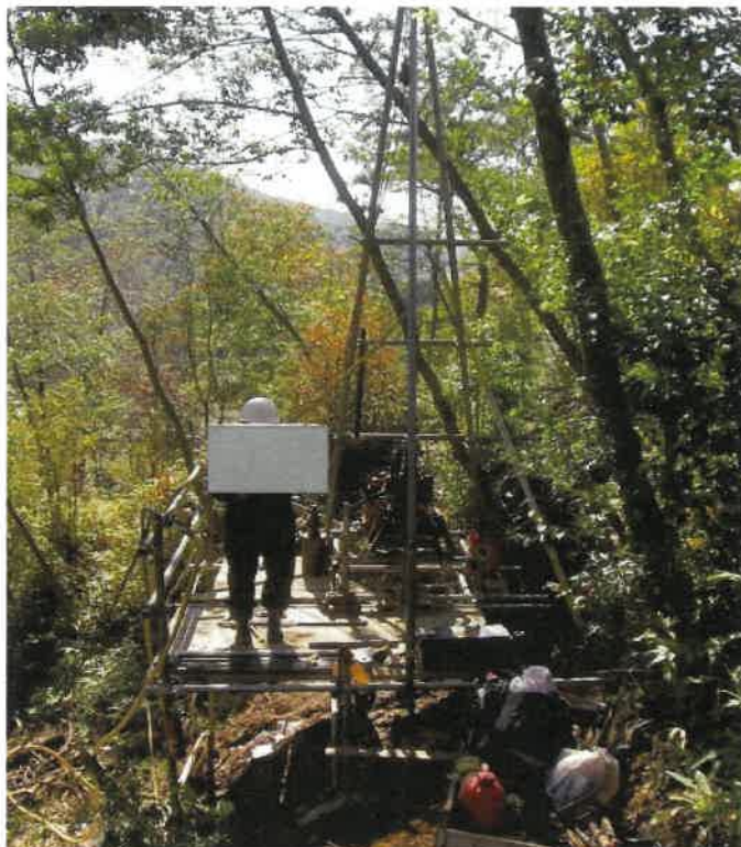
ボーリング調査、足場仮設状況の例
