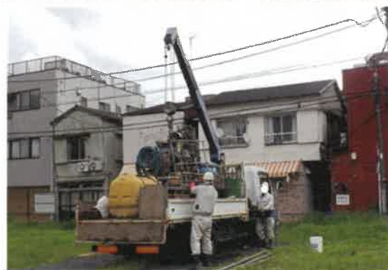
クレーン付きトラックによる機材搬入の例
