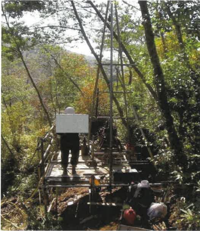
ボーリング調査、足場仮設状況の例
