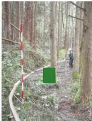
モノレールによる機材搬入の例
