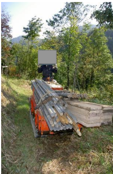
運搬車による機材搬入の例
