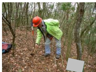
掘削した深さ 50cm 程度の発破孔に火薬を充填し防爆シートを被せた上で発破します
