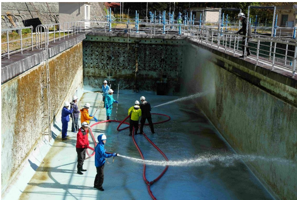
東俣浄水場の清掃作業
