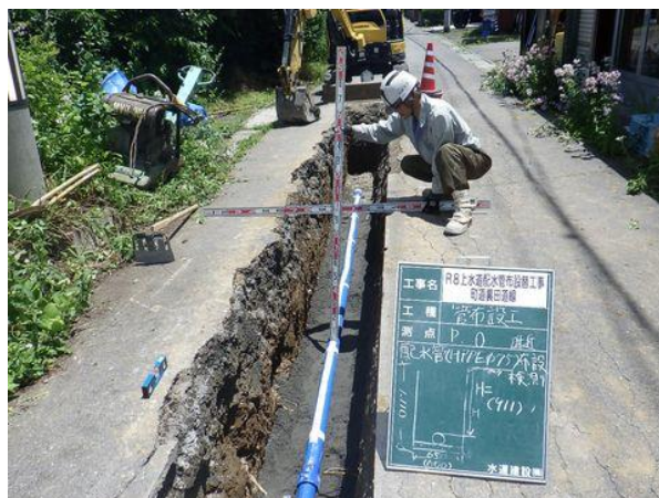
配水管布設替工事の現場
