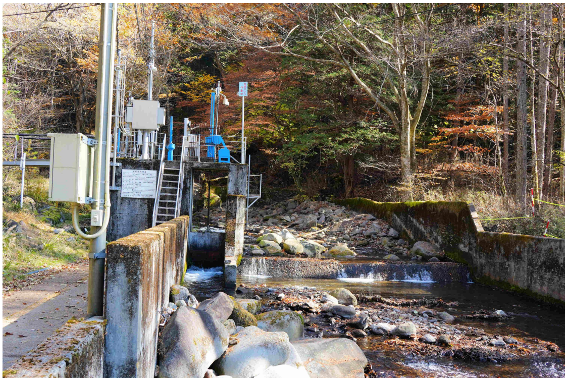
東俣浄水場 取水口
